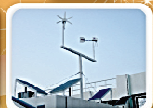
風力發電設備
